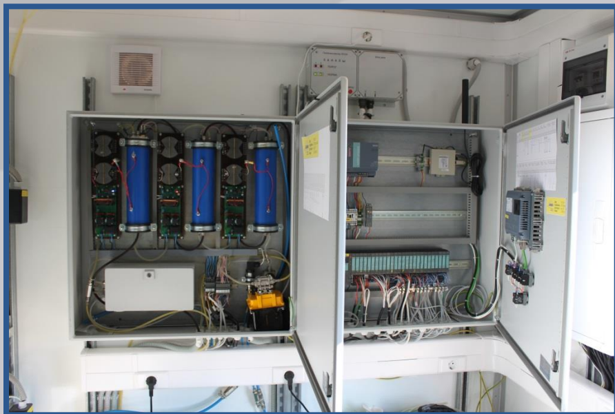
Блок генераторов озона
